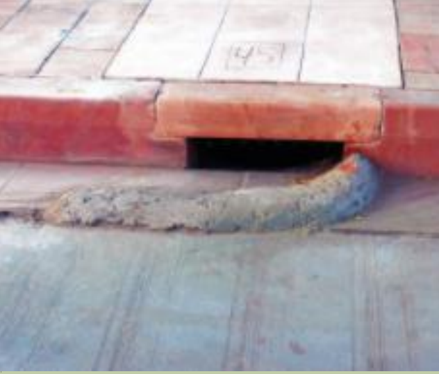
सड़क किनारे जल निकासी के लिए प्रवेशिका स्रोत: सी एस ई इंडिया
